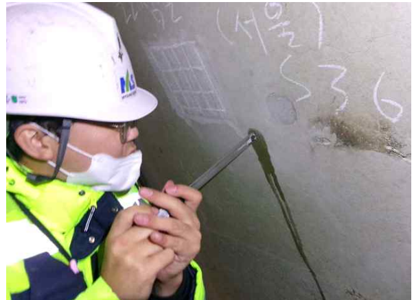
탄산화깊이 측정 현황
